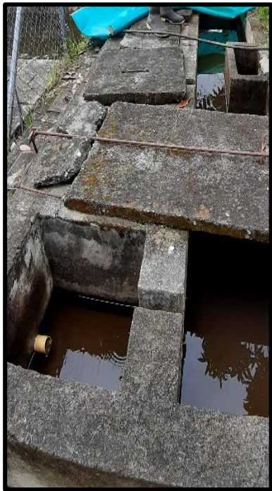
Imagen 10 Obra de reparto.
