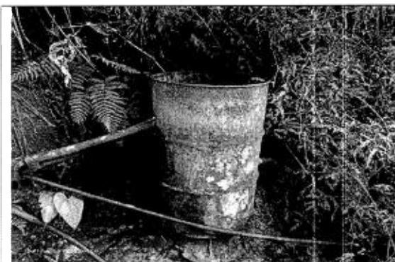
Foto 3: Captación en tanque metálico de 200 litros.
