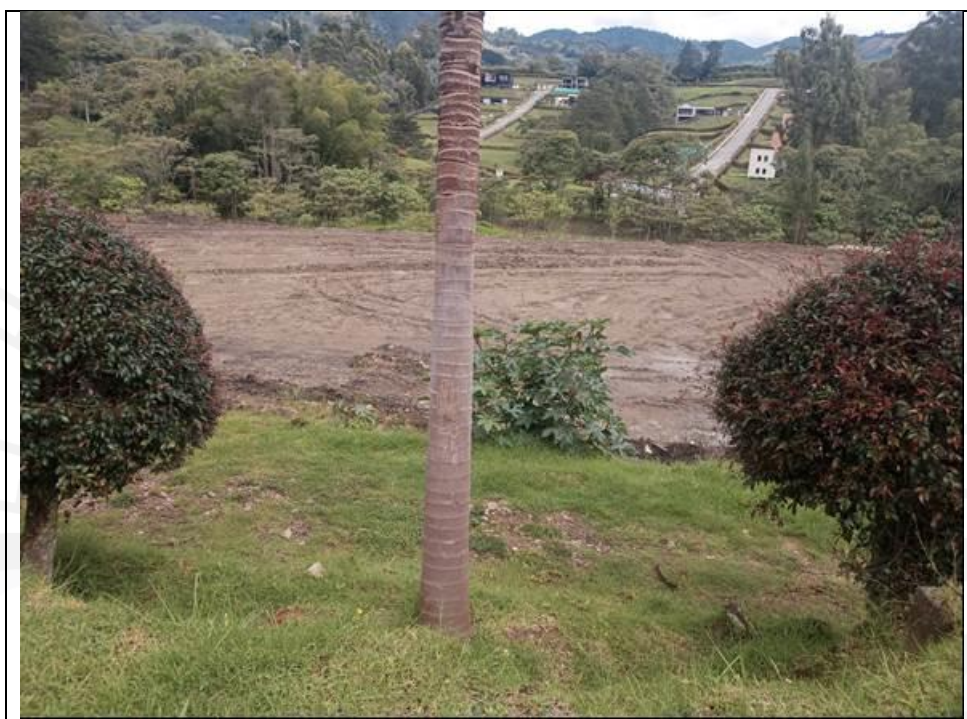
Adecuaciones del terreno
