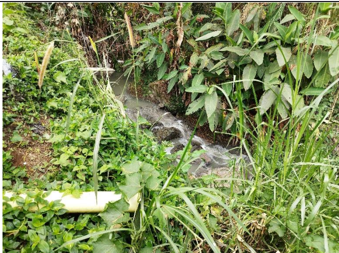
Tubería de descarga de aguas residuales
