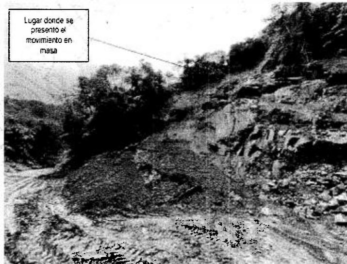
Foto 3. Suelo desplazado debido a un movimiento en masa
