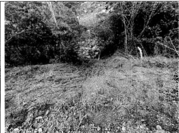
Figura 7. Talud cerca al río Dormilón, antes.
