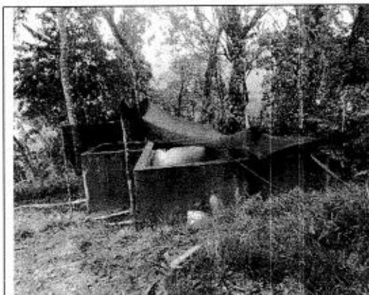
Figura 12. Tanques de almacenamiento de agua.
