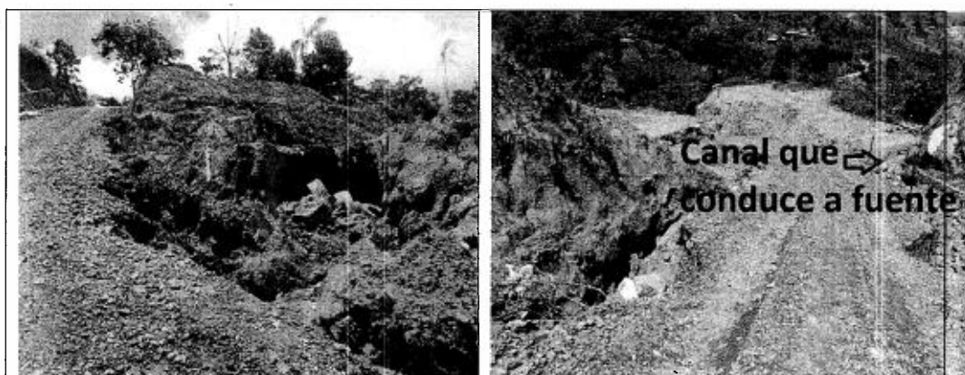
Imágenes 21 y 22. Proceso erosivo tipo cárcavas y corte de taludes, que afecta una corriente.
