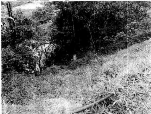
Figura 8. Talud cerca al río Dormilón, después.
