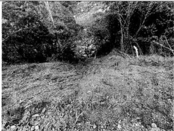
Figura 7. Talud cerca al río Dormilón, antes.
