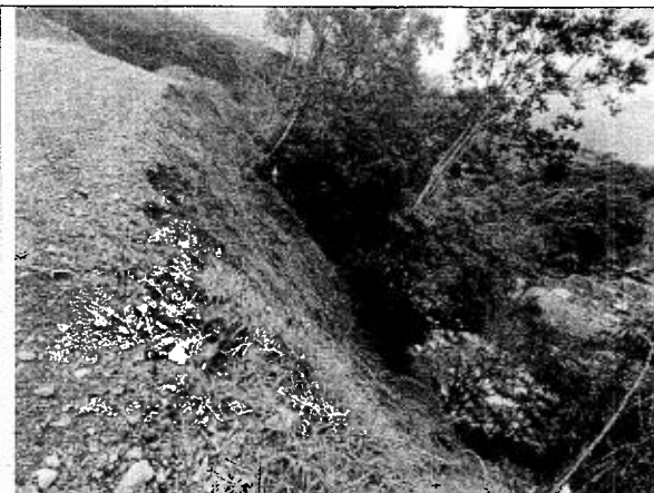
Imagen 9. Apertura de vía cerca al río Dormilón
