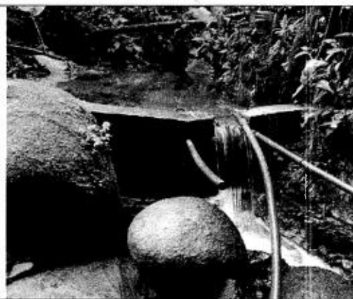
Imagen 14. Obra de captación de donde se conduce el recurso hasta los tanques.
