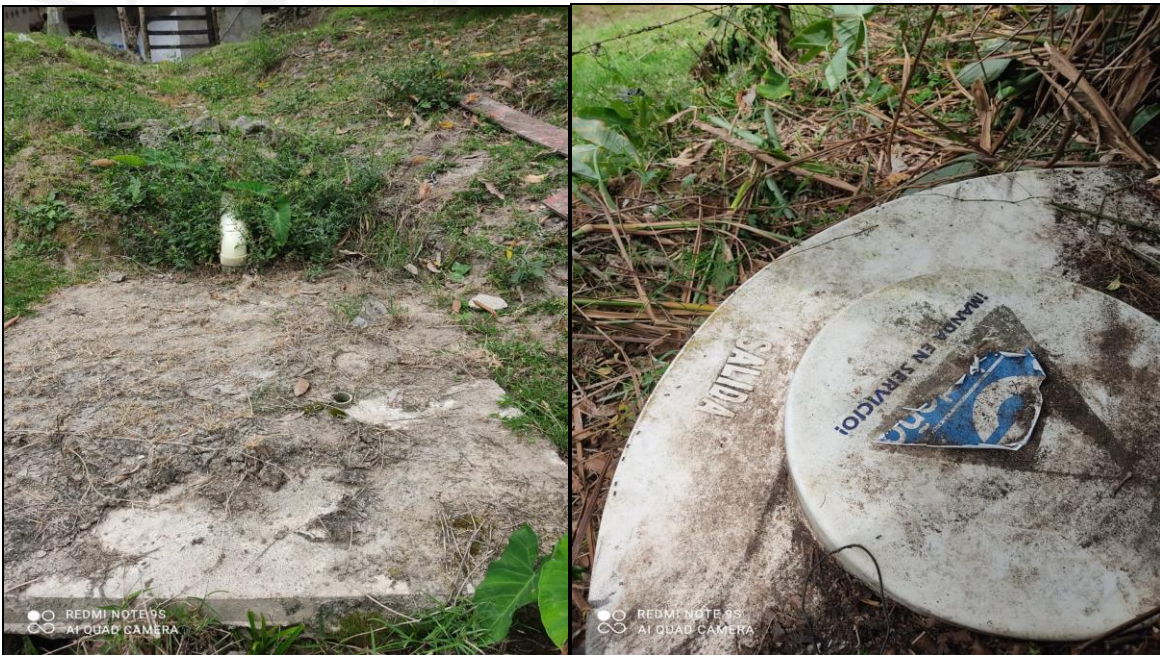
Pozo Séptico Mampostería
