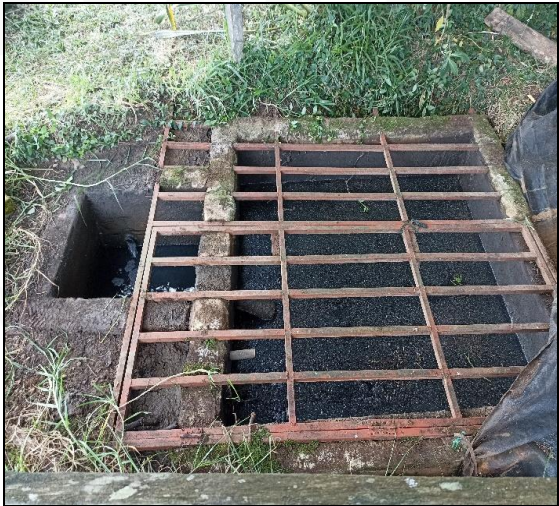
Sitio de captación predios vecinos
