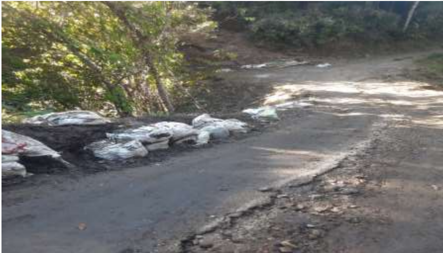
Bolsacreto implementado para evitar la sedimentación por escorrentía
