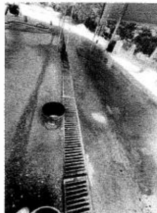
Foto 7 y 8. Zona de lavado de carros para cemento y cárcamo que recoge aguas generadas del lavado para ser conducidas al STARnD.
