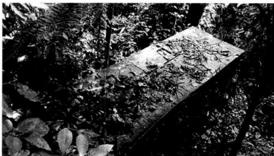
Foto 16. Sistema de tratamiento de aguas residuales domésticas STARD. Lavadero Las Brisas No.2.
