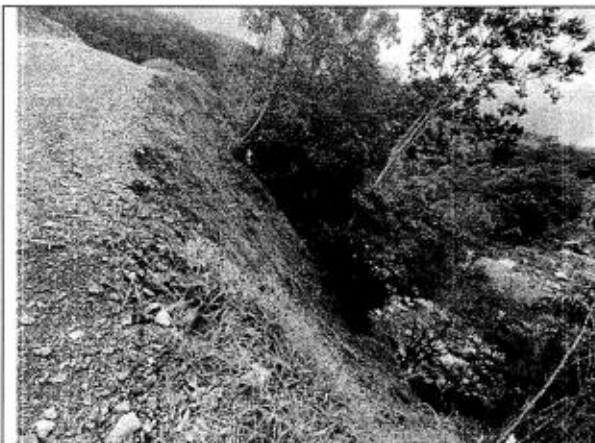
Imagen 9. Apertura de vía cerca al río Dormilón
