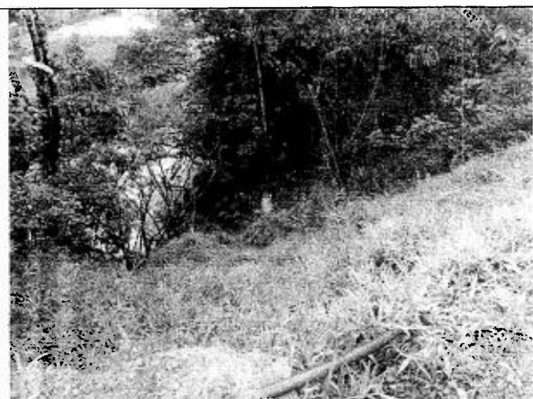
Figura 8. Talud cerca al río Dormilón, después.
