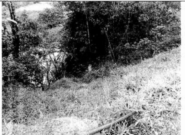
Figura 8. Talud cerca al río Dormilón, después.
