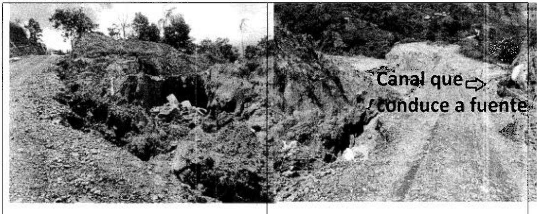
Imágenes 21 y 22. Proceso erosivo tipo cárcavas y corte de taludes, que afecta una corriente.
