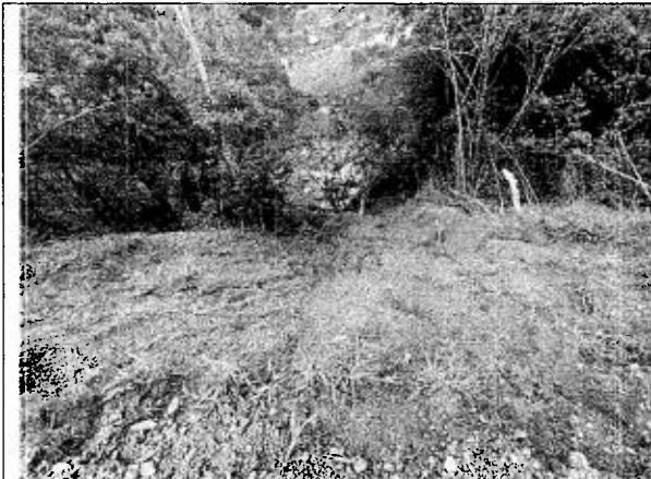
Figura 7. Talud cerca al río Dormilón, antes.
