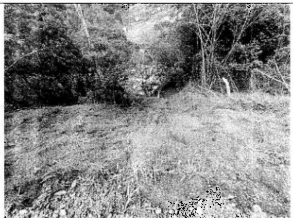
Imagen 10. Talud erosionado, depositando sedimentos al río Dormilón.
