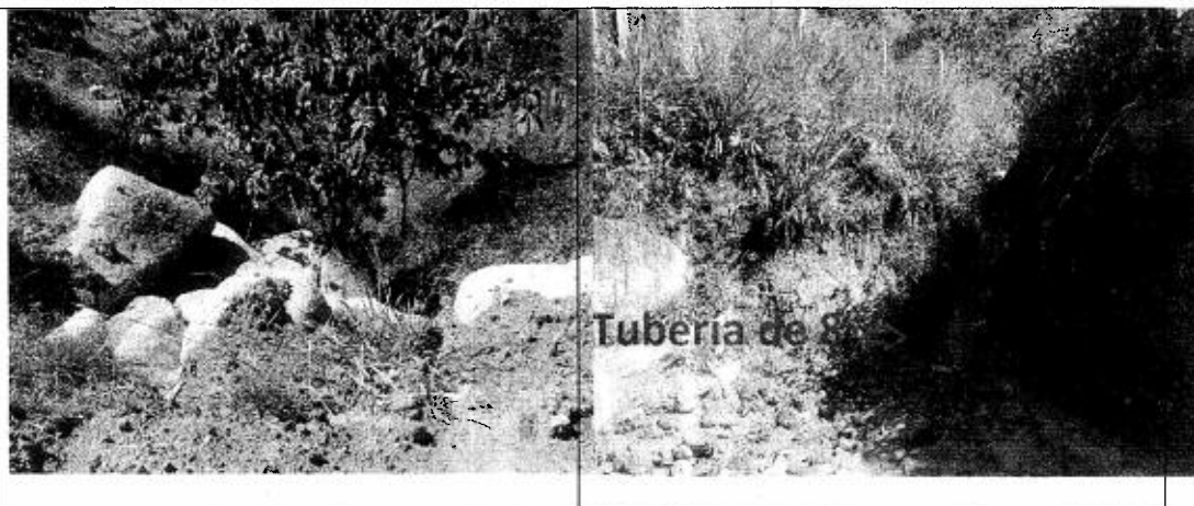
Imágenes 17 y 18. Obra de ocupación de cauce de fuente con tubería de 8 pulgadas, para cruzar vía.
