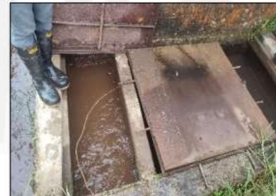
Figura 3. Tanque de almacenamiento
