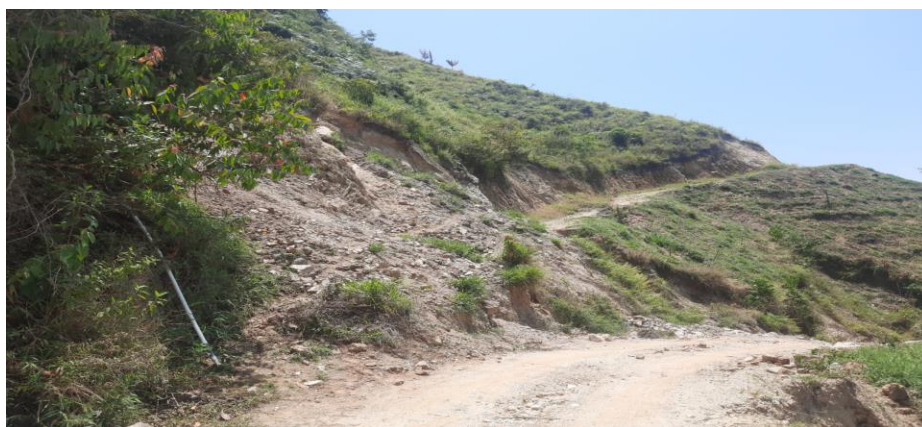
Inicio de la apertura de vía con taludes retornando a sus condiciones iniciales, se evidencia la actividad de revegetalización, lo que impide el arrastre de material a la carretera veredal Fotografía 2
