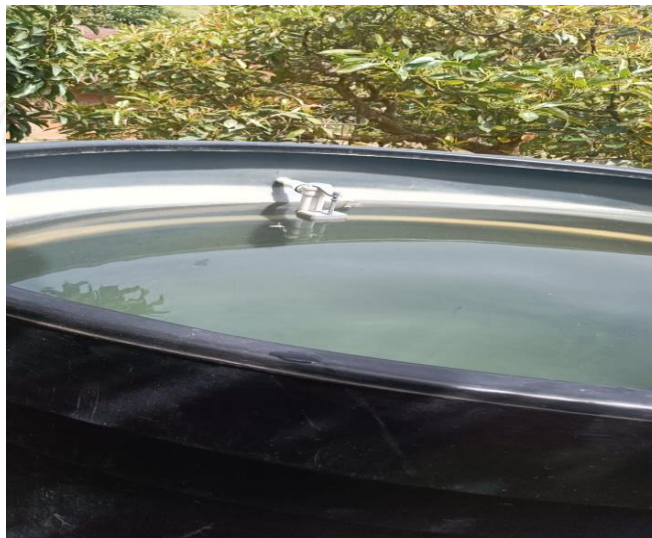
Tanque de almacenamiento con sistema de control de flujo tipo Flow Master
