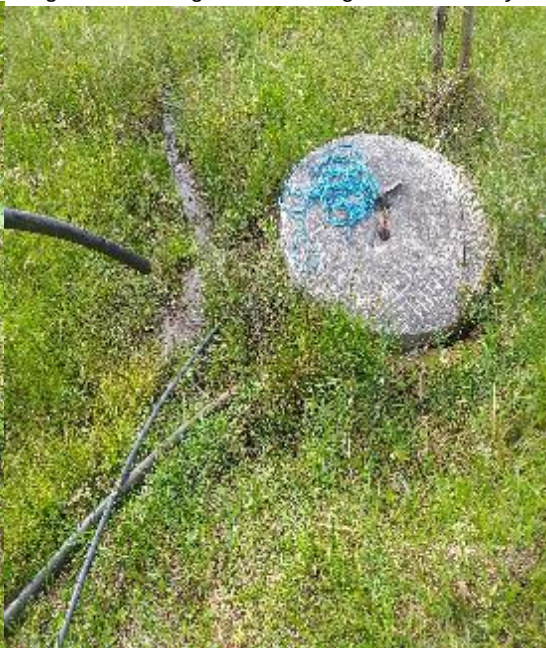
Imagen 2; descarga de las mangueras a suelo y al aljibe
