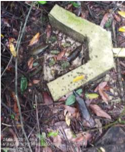
Imagen4. Obra de descarga.
