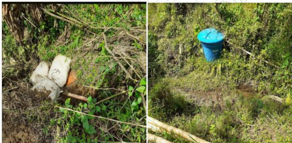
Construcción de muro en costales para represamiento del recurso
