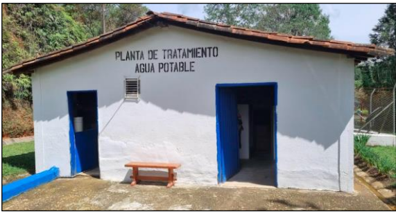
Imagen 8. Planta de tratamiento.
