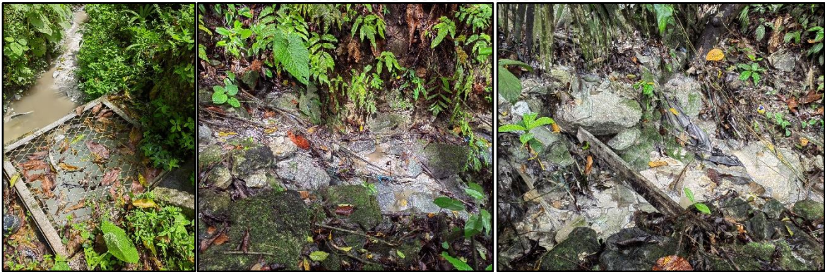
Imagen 6. Cornare. 2023. Rejilla implementada por Omya Andina S.A.S., para la retención de sólidos y estado del cauce donde transcurren las escorrentías de aguas lluvias.
