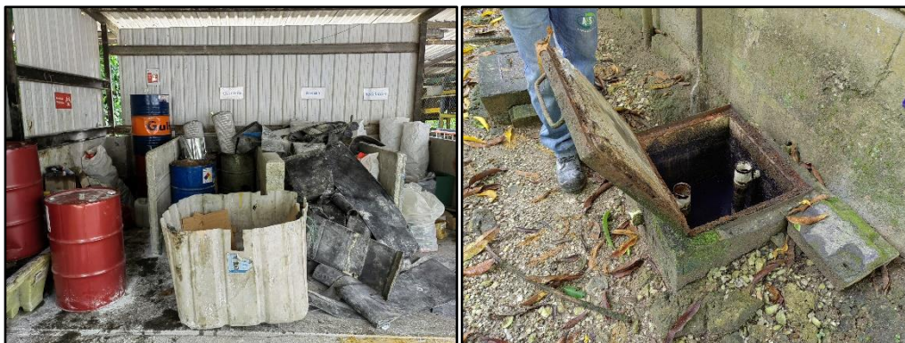
Imagen 7. Cornare. 2023. Área de disposición de RESPEL y trampa de seguridad para evitar el derrame de aceites.
