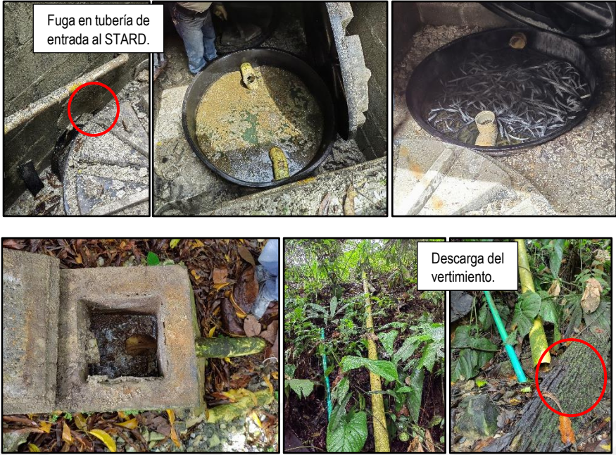
Imagen 5. Cornare. 2023. STARD implementado por Omya Andina S.A.S., para el tratamiento de ARDs.
