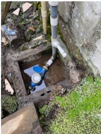
Imagen 6 macromedidor salida planta
