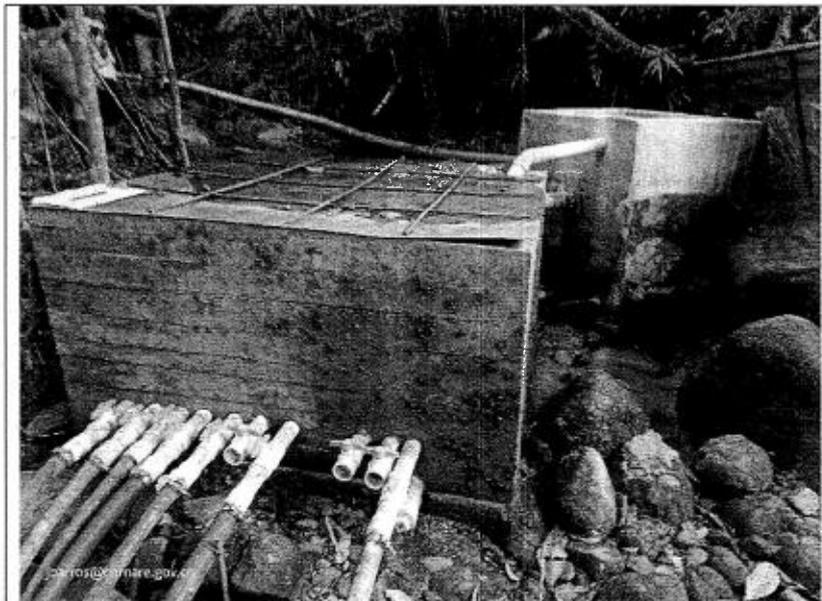
Imagen 4: Tanque en concreto reforzado para almacenamiento y distribución de agua.
