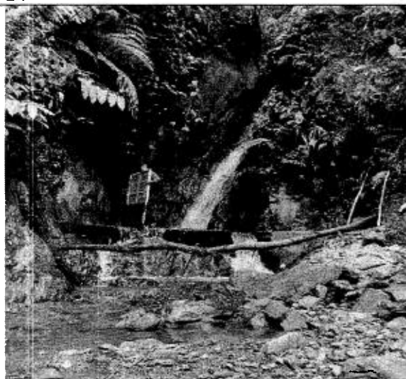
Imagen No. 1 Bocatoma fuente hídrica Quebradona
