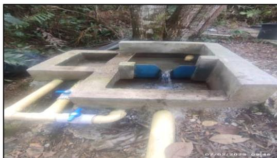
Figura 1. Obra de derivación y control en la fuente denominada El Seminario
