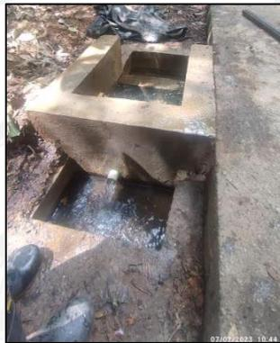
Figura 3. Obra de derivación y control de caudal fuente denominada Luis Arenas.
