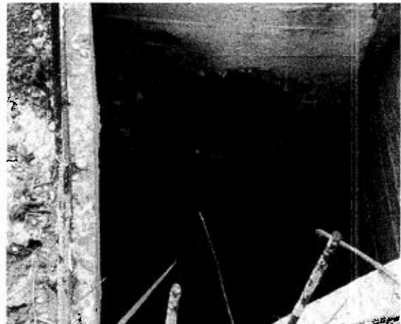
Foto 4. Descole de tubería en concreto, donde se aprecian la salida de las ARd de las viviendas localizadas en la parte alta.
