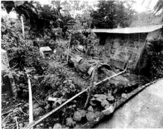
Foto 1. Salida de tuberías de ARd, sobre fuente hídrica.
