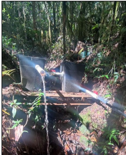
Figura 1. Obra de captación y derivación de caudal
