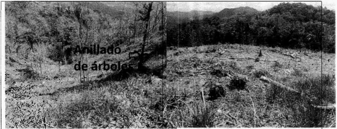
Imágenes 23 y 24. Anillado y tala de árboles aislados.
