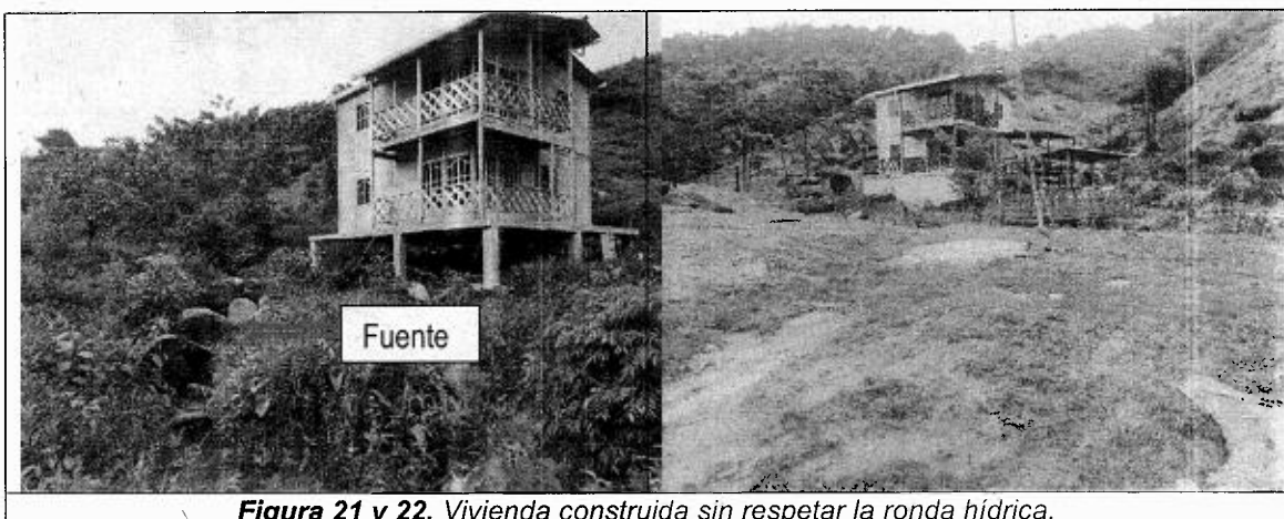
Figura 21 y 22. Vivienda construida sin respetar la ronda hídrica.
