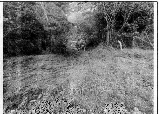
Imagen 10. Talud erosionado, depositando sedimentos al río Dormilón.
