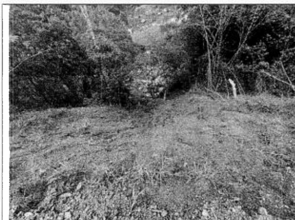
Figura 7. Talud cerca al río Dormilón. antes.
