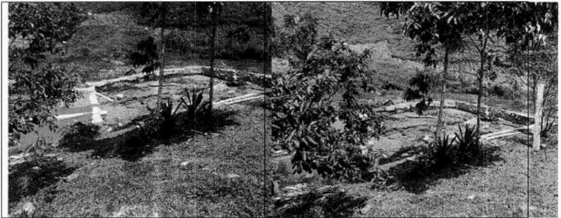
Fotos 11 y 12. Obra de ocupación de cauce en predio identificado con FMI 018-168519
