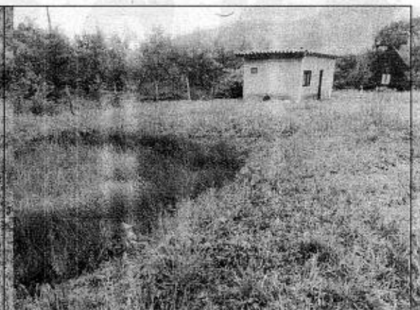
Figura 20. Vivienda construida en la ronda hídrica.
