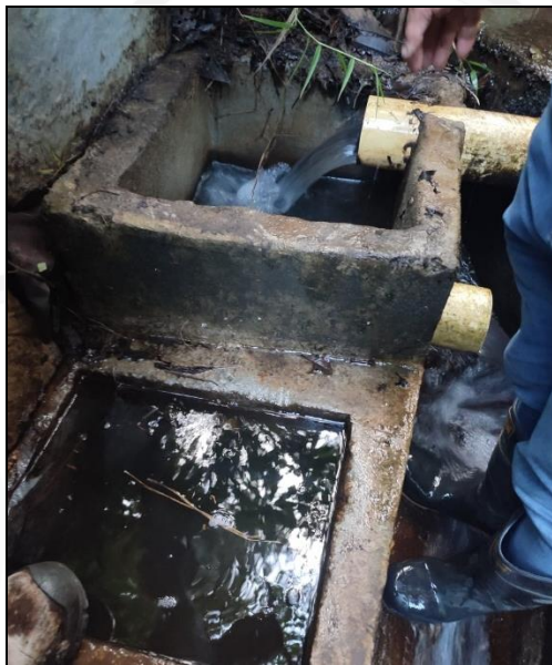
Figura 3. Obra de control Fuente Sin Nombre 2
