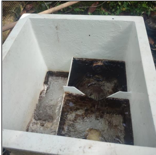
Figura 2. Obra de control Fuente Sin Nombre 1 Captación 2
