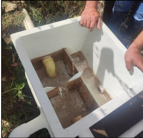
Figura 1. Obra de control Fuente Sin Nombre 1 Captación 1
