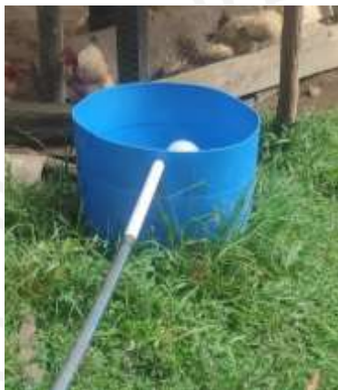
Figura 3. Tanque de almacenamiento de la fuente Tinaja I
