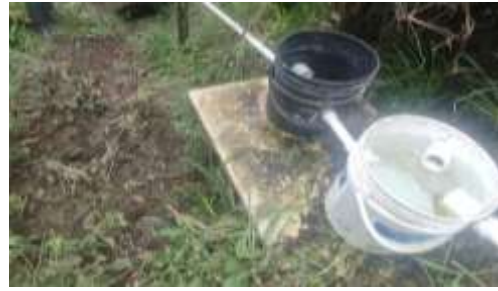
Figura 2. Obra de captación y control fuente Tinaja II
