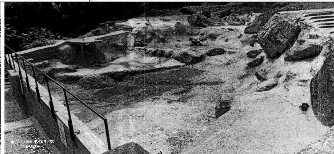
Imagen 2: Piscina artesanal con recubrimiento de paredes y piso en cemento
