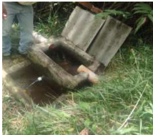
Figura 1. Obra de captación Fuente 1
