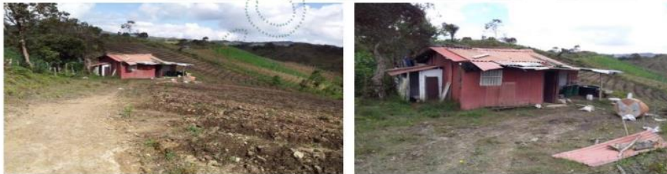
Figura 1: Imágenes de la infraestructura y áreas perimetrales, donde no se evidencia la implementación del sistema séptico para el tratamiento de aguas residuales.
