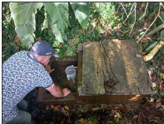
Figura 1. Obra de captación y derivación de caudal
