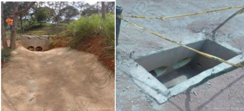
Foto 5 y 6: Construcción de cunetas y obras transversales.
