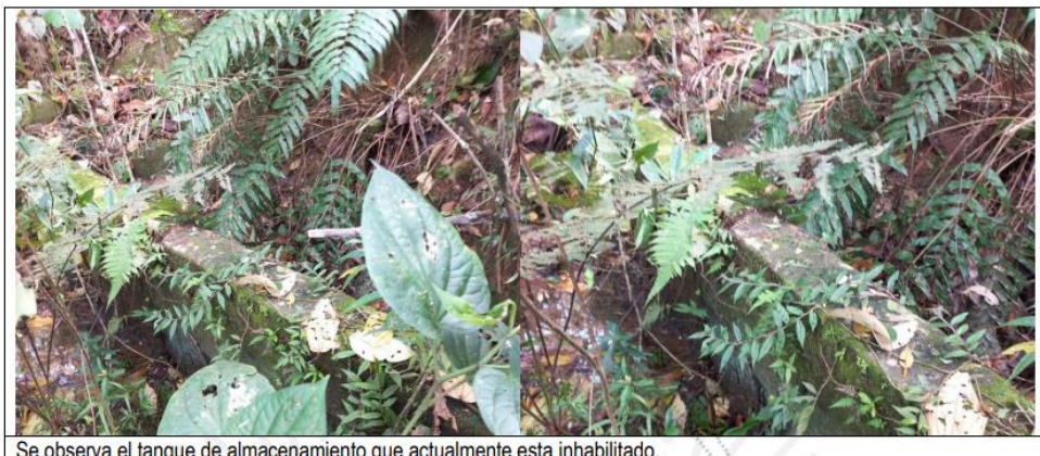
Se observa el tanque de almacenamiento que actualmente esta inhabilitado.
