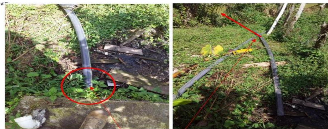
Imagen de la manguera instalada y la descarga al Rio Concepción
