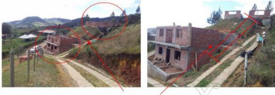
Figura 1: Imágenes de las infraestructuras en construcción
