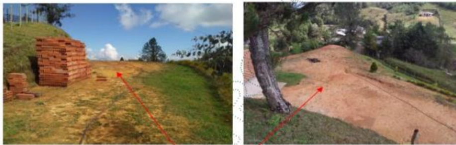
Figura 2: Imágenes de las explanaciones existentes en el lugar
