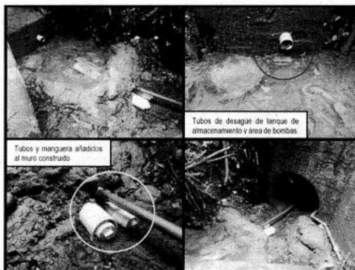
**Imagen 2.** Cornare. 2023. Muro implementado para la retención del agua excedente de captación del acueducto.
