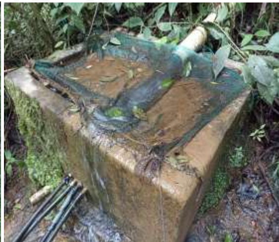
Obra de Captación
