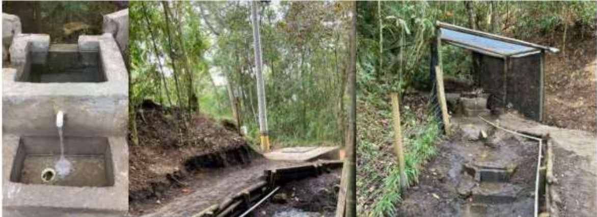
Registro fotográfico del ajuste de la obra de captación entregada por Comare en la fuente Arrayanes 1.
