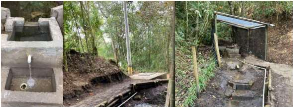
Registro fotográfico del ajuste de la obra de captación entregada por Cornare en la fuente Arrayanes 1.
