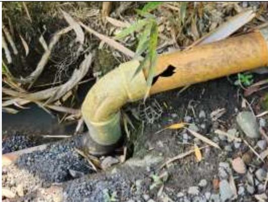
Tubería de conducción de ARnD con fuga
