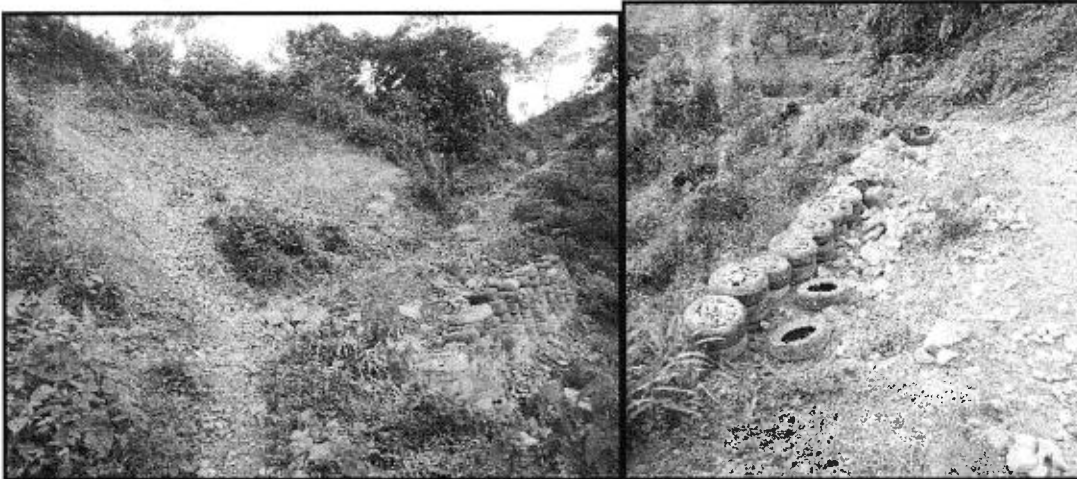
Imagen 2. Cornare. 2022. Posible fuente intervenida, talud detectado e implementación de llantas para evitar derrumbe.
