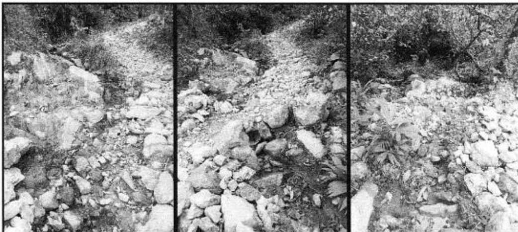
Imagen 4. Cornare. 2022. 2da fuente hídrica intervenida para el establecimiento de la vía.
