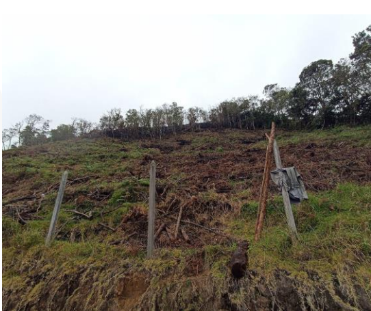
Ingreso al lote afectado
