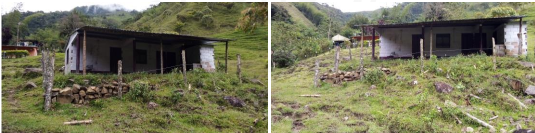
Vivienda donde funciona la escuelita y que hacen el vertimiento sin tratamiento
