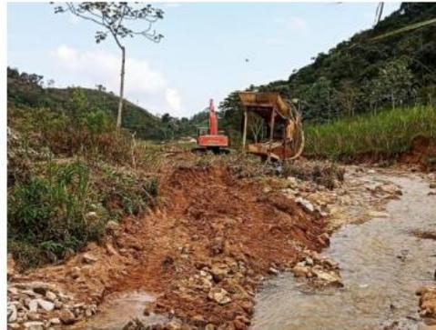
Foto 4. Retroexcavadora realizando remoción de material en lecho y riveras del afluente. Fuente: Cornare, 2022.
