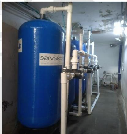
**Imagen 1.** Implementación nuevo sistema de filtración (Batería de filtros).
