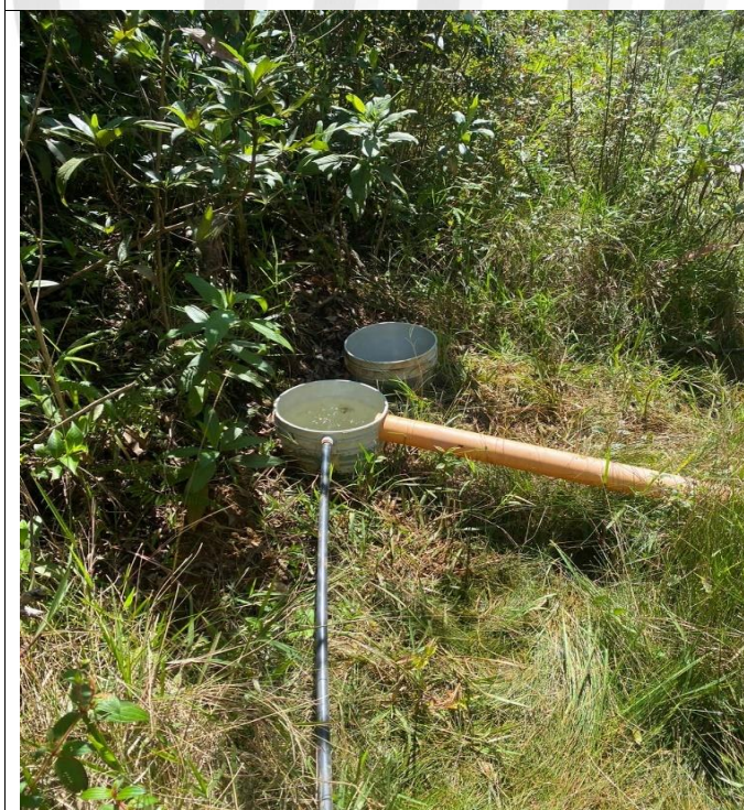
Imagen 2: Obra De Captación Y Control Fuente "La Pesebrera"
