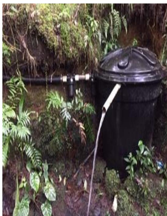
Imagen 4: Tanque Desarenador
